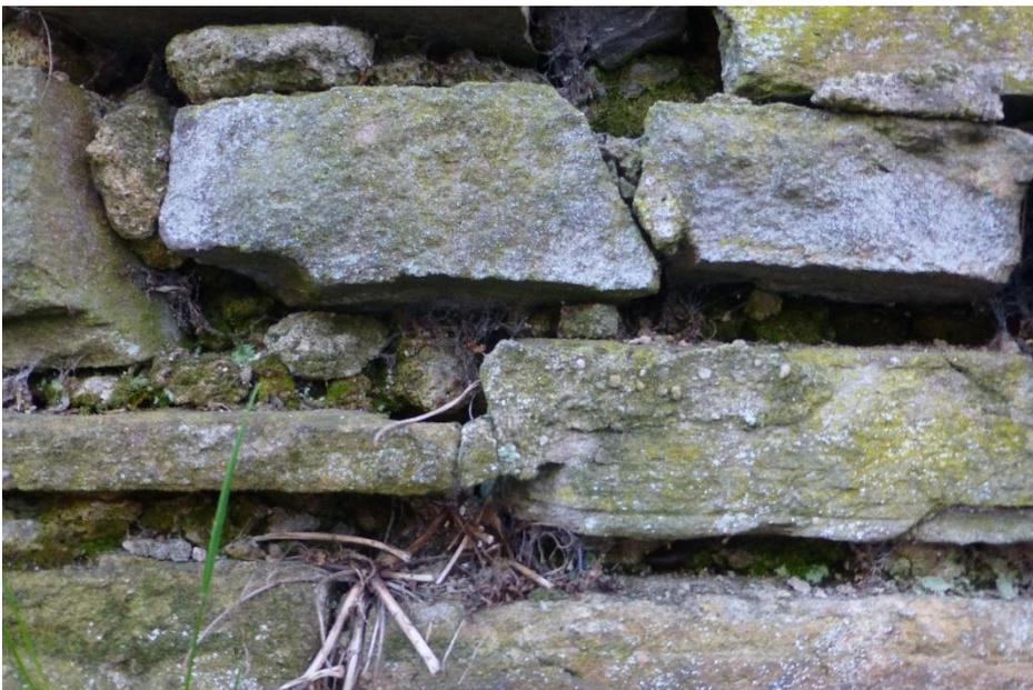
Das Brückenbauwerk aus Sandstein weist Fugenlücken auf.
