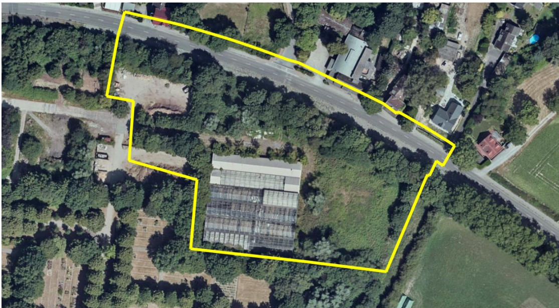
Abbildung 4: Luftbild von der Stadtgärtnerei und Zeppelinstraße vor der Baufeldräumung (Quelle: Tim-Online 2.0 NRW, Orthofoto und ALKIS, 01.10.2024)
