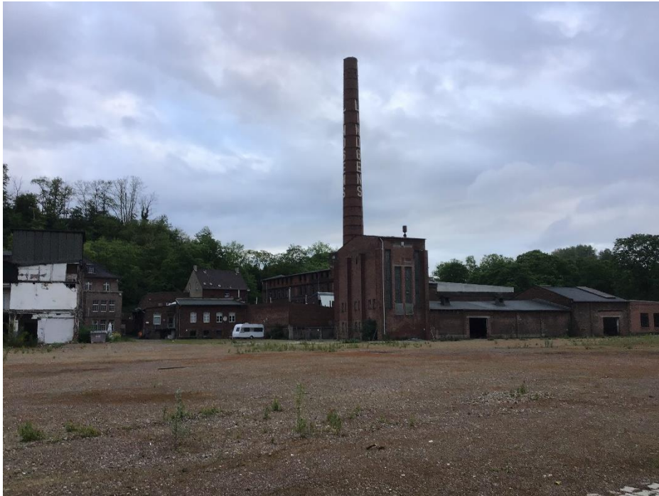
Blick über das Plangebiet, mit ehemaliger Lederfabrik Lindgens.
