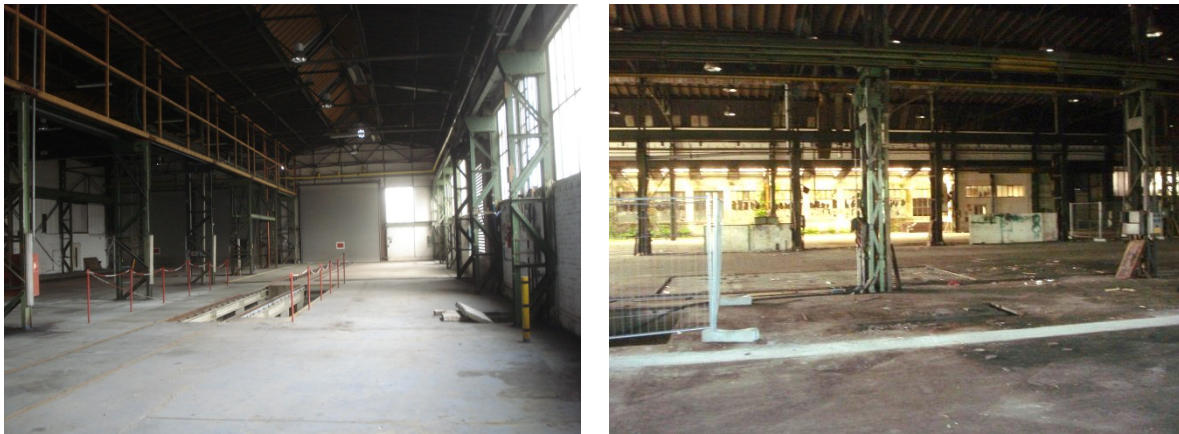
Abbildung 14 und 15: Ausschnitt der beiden abzureißenden Hallen, die hinsichtlich einer Besiedlung durch Fledermäuse kontrolliert wurden. (Fotos biopace)
