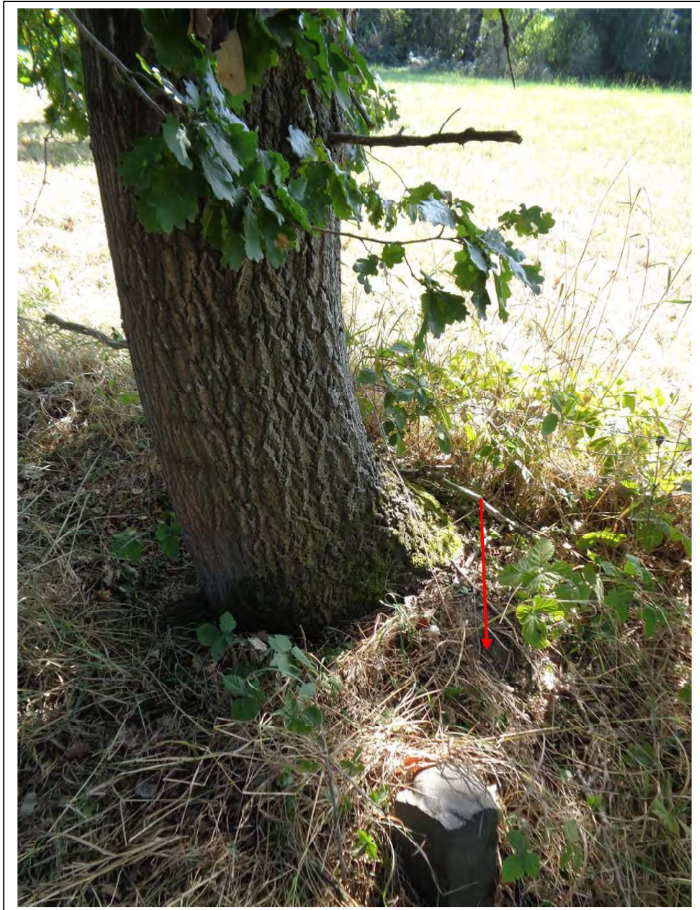
Vormals anscheinend partiell leicht angehobener Wurzelbereich der Espe - Nr. 43 (s. Pfeil)
