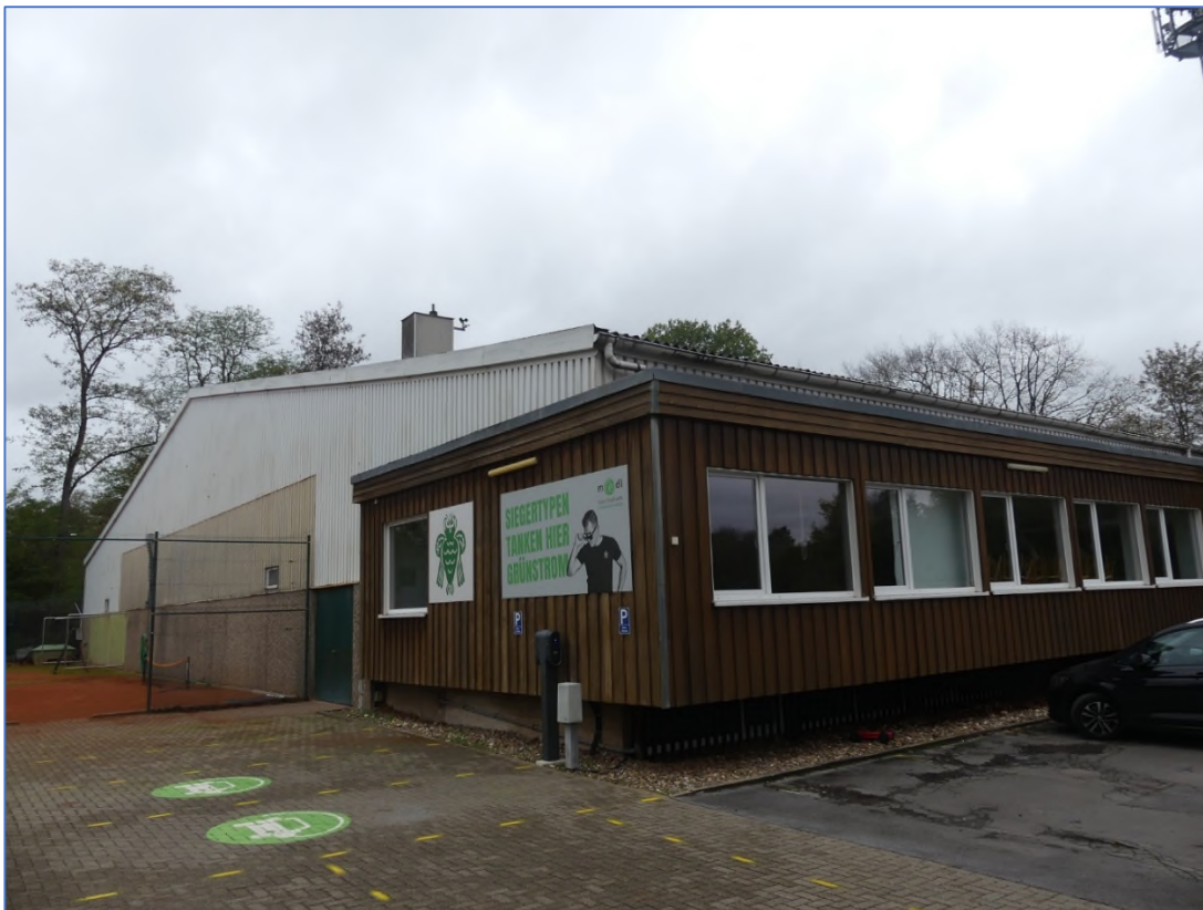
Abb. 6: Hockey- und Tennishalle auf dem Gelände der Sportanlage des HTCU (Foto: ILP 2022)
