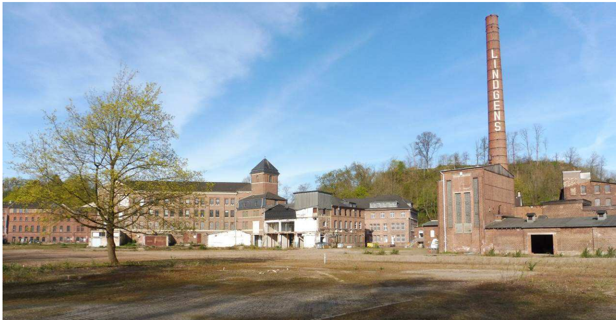
Abb.2: Das ehemalige Betriebsgelände und der Gebäudebestand auf dem Lindgens-Areal.
