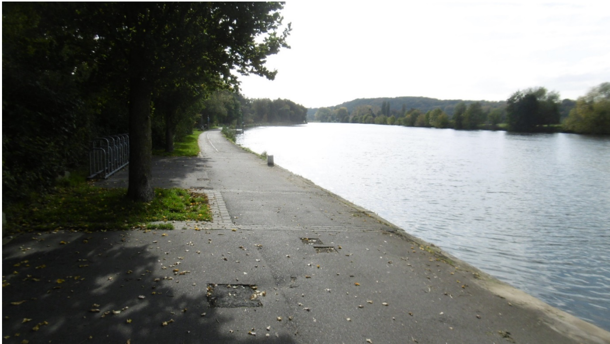
Abbildung 10: Blick entgegengesetzt zur Fließrichtung entlang des rechten Ufers der Ruhr
