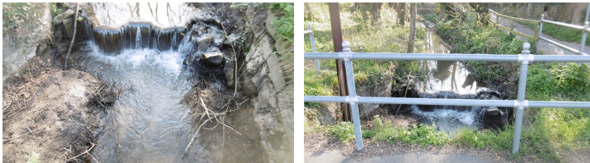
Abbildung 4 und 4a: Blick vom Leinpfad auf das Querbauwerk im Forstbach im Mündungsbereich zur Ruhr.
