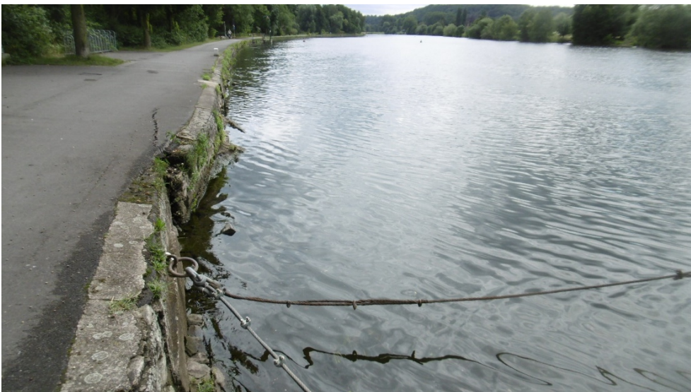
Abbildung 3: Blick auf die Ufermauer des Leinpfades.
