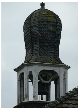
Abbildung 28: Zwiebelturm über der Glocke, Zugang mit Kaninchendraht verschlossen (rechts)
