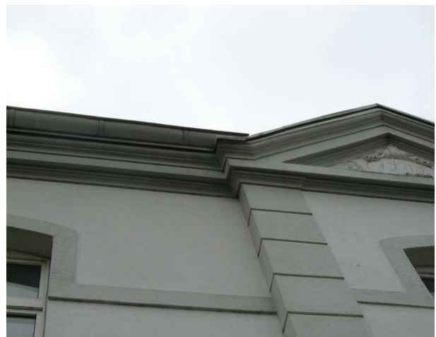
Abbildung 10: Verkleidung Dachrinne Hausoberkante
