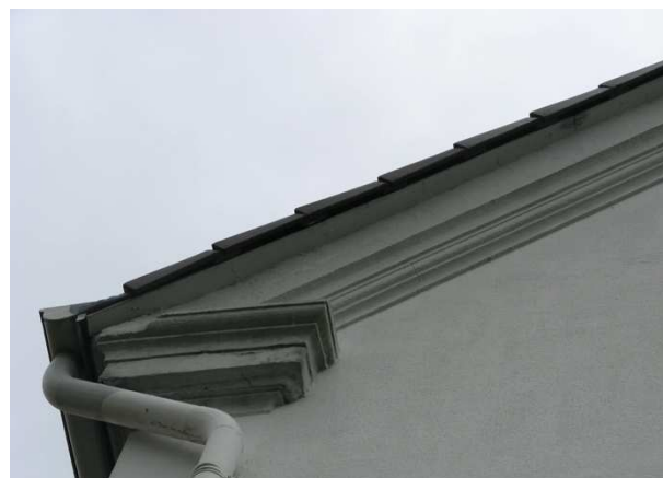
Abbildung 3: Abstehende Dachziegel
