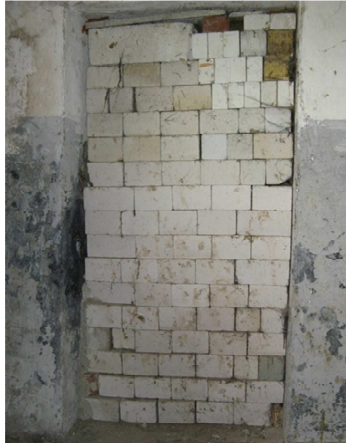
Abbildung 17: Lose zugemauerter Türrahmen
