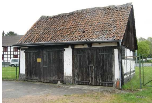
Abbildung 26: Fachwerkschuppen (Einsturzgefahr)
