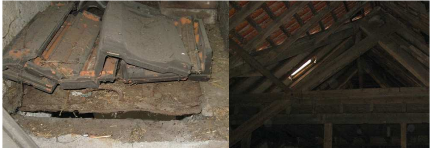
Abbildung 18: Zugangsmöglichkeiten zum Scheunenboden, Dachluke (links), lose Dachziegel (rechts)
