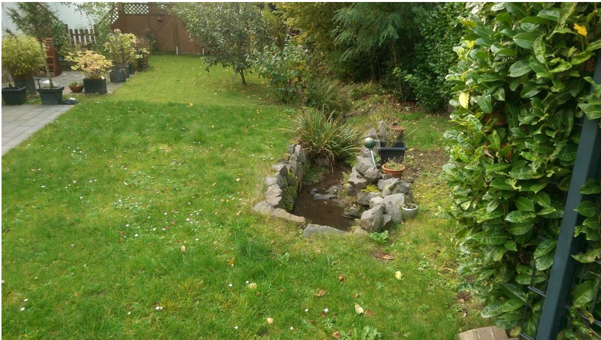
Abbildung 1: Heubach Ist-Zustand Einlauf in die Verrohrung, Heuweg Nr. 8
