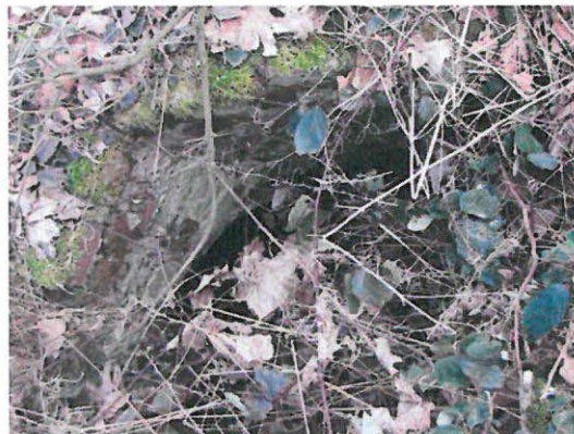
Abb. 5: Ziegelsteinfassung und Rohrauslass der Quelle Q1
