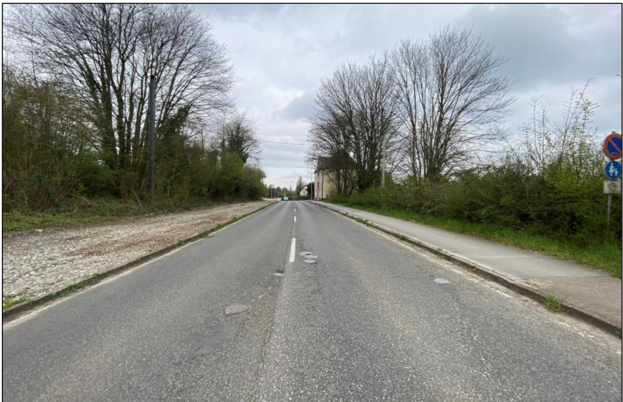
Abbildung 2: Derzeitige straßenräumliche Situation der Zeppelinstraße, Blickrichtung Westen [Quelle: eigene Aufnahme]
